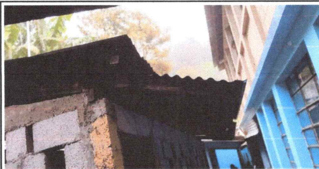
Foto 5: MODULO 3 (EXTERIOR COCINA)
